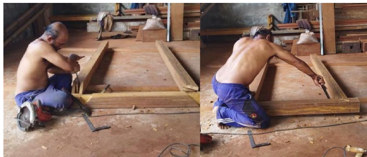
Gambar 4. Proses pembuatan konstruksi dan perakitan konstruksi
