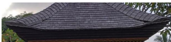
Gambar 19: Sirap Tumpuk 7, Sanggah Rong Tiga. (Sumber: Putra Suryadana, 2020)
