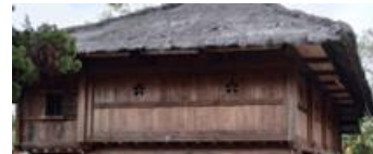
Gambar 7(b). Dinding Samping Bangunan
