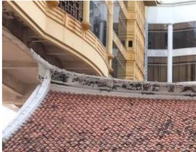
Gambar 1. Atap Lengkung Candra Naya (Sumber : Dokumentasi Pribadi, 2022)
