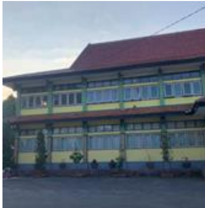
Gambar 4.5 Dokumentasi Bangunan Eksisting (Sumber : Data Pribadi, 2021)
