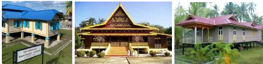
Gambar 7. Rumah Singgah Tuan Kadi, Selaso Jatuh Kembar, Rumah Limas Potong (Sumber : Dokumentasi Pribadi, 2021 ; RiauOnline.co.id 2021 ; Kompasiana.com, 2020)
