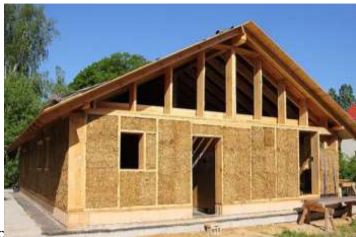
Gambar 4 : Rumah Dengan Batang Jerami Sebagai Bahan Dasar Konstruksi ( Sumber : Yuk, Intip Desain Rumah Jerami yang Ramah Lingkungan , 2020 )
