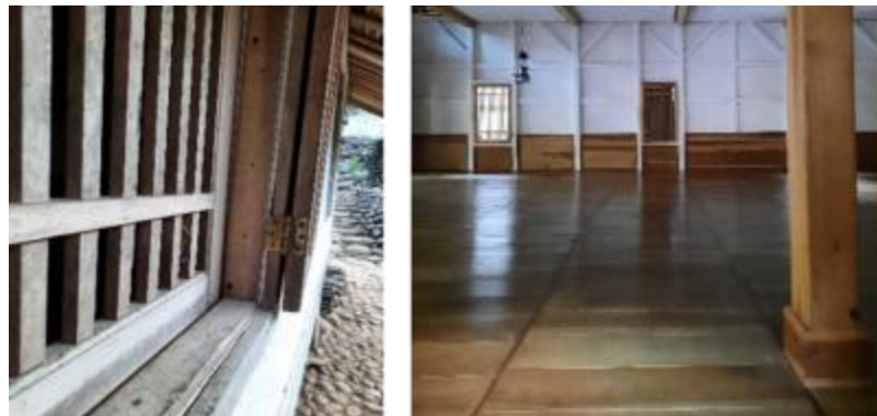
Gambar 9. Kayu untuk kusen, tiang dan lantai masjid ( Sumber : Nelsa, 2021)
