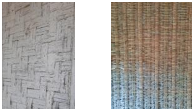
Gambar 5 & 6. Dinding anyaman biasa (kiri) dan anyaman sasag (kanan) (Sumber : Nelsa,2021)
