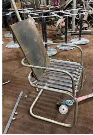
Gambar 20. Pemasangan Plat Besi (Sumber: Dokumen Penulis, 2024)
