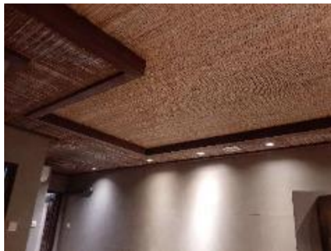
Gambar 10. Implementasi Plafon Material Eksploratif Dengan Anyaman pada Toilet Sumber : Dokumentasi Pribadi (2024)
