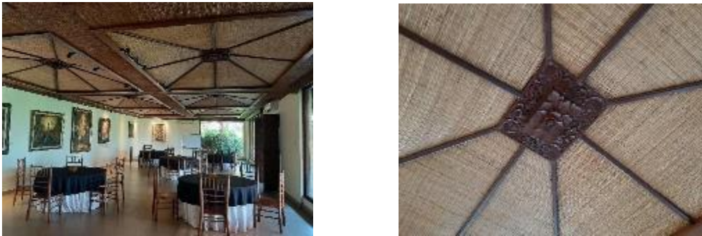
Gambar 9. Implementasi Plafon Material Eksploratif Dengan Anyaman pada Ruang Pameran Sumber : Dokumentasi Pribadi (2024)
