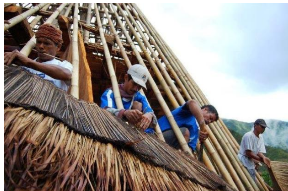
Gambar 9. Proses Pemasangan Atap (Sumber: hdesignideas.com , 2019)
