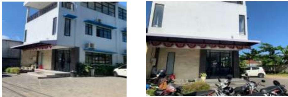
Gambar 2. Fasad Klinik Kecantikan WG (Sumber: Dokumen Penulis, 2024)
