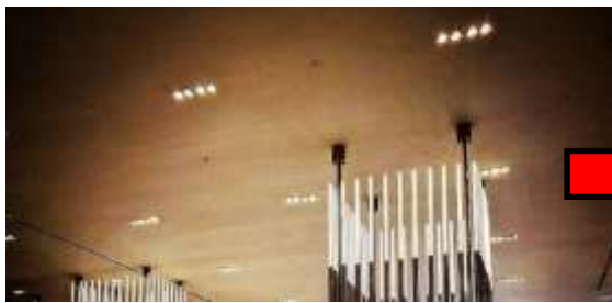
Gambar 14. Plafon Lobi Hotel (Sumber : google.photo)
