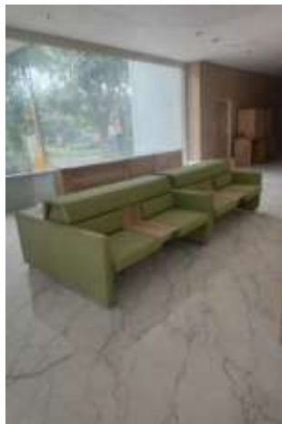
Gambar 5 Hasil pemasangan lantai vinyl di lobby gedung B Persada Hospital Malang Sumber: Dokumentasi penulis, Desember 2025
