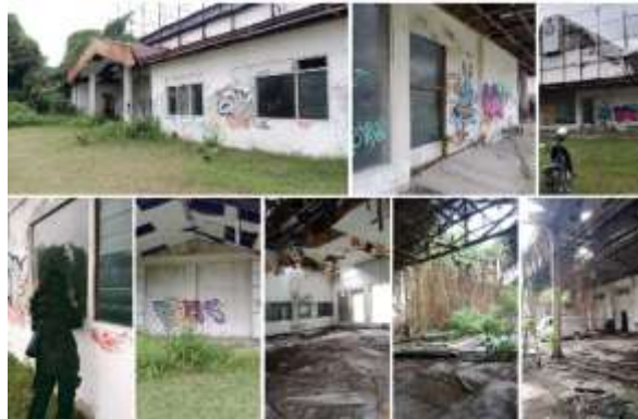
Gambar 5. Kondisi Eksisting Bangunan (Sumber : Dokumentasi Pribadi, 2025)
